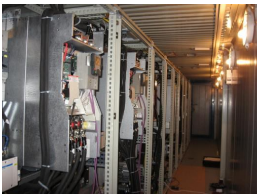
Система электропривода и управления крана грузоподъемностью 120т
