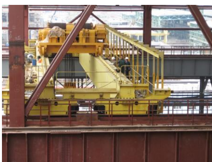
Монтаж электрооборудования крана грузоподъемностью 90т
