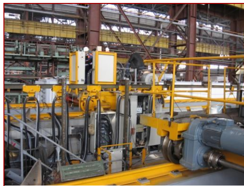
Монтаж крана 32/32т
