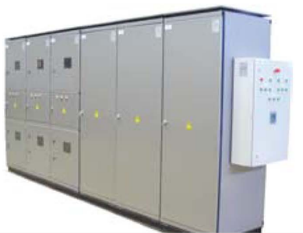
Система автоматического управления плавным пуском группы электроприводов
